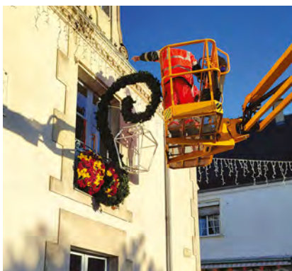
Durant la pose des illuminations.
