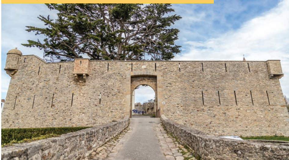
La façade sud du château a été restaurée
